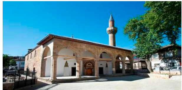
5.37: Rüstem Paşa Camii
